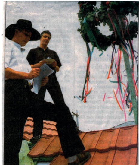
NEUBAU MACHT FORTSCHRITTE: Die neue Sozialstation in Günzerode feierte gestern ihr Richtfest. Zimmermann Steffen Hellmuth verlas den Richtspruch und wünschte dem Bau nur Gutes. Worte, die Pfarrer Michael Wegner vom Diakoniewerk (Träger der Station) gern hörte. TA-Fotos (2): H. LANGNER
