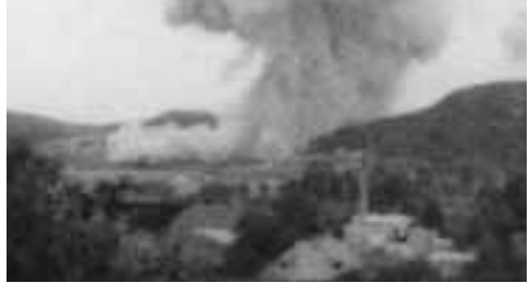
Großsprengung an den A- und B-Stollen (Ostern 1949)
